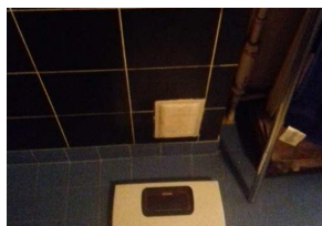
- Grilles d'entrée d'air (bas) et de reprise (haut) -
