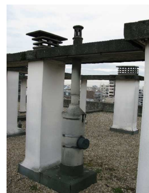
- Sorties de conduits shunt en toiture -
