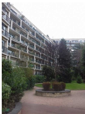
- Façade sur cour -
