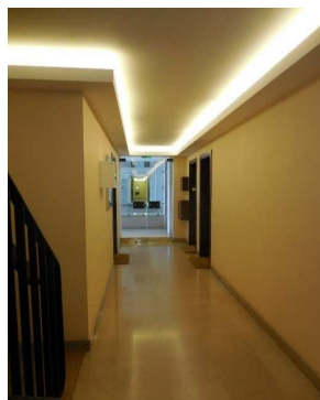
- Eclairage des circulations -
